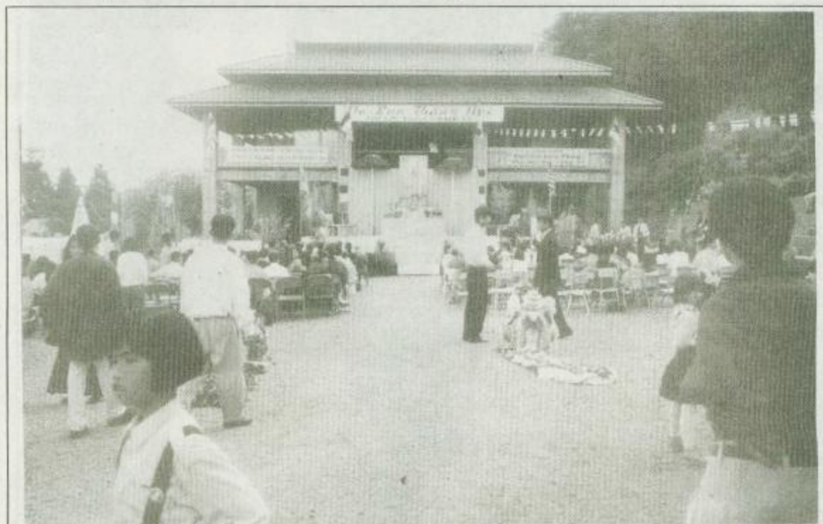
Chùa Cổ-Lâm ở Seattle do Thượng-Tọa Thích-Nguyên-An đứng ra xây dựng chỉ mới được hình thức bên ngoài. Bên trong chùa xong, công trình xây cất mới được một nửa. Rất mong bốn phương Phật tử và Đồng hương phát tâm ủng hộ để cho ngôi Tam-Bảo sớm được hoàn thành để có nơi tu học cho Tăng Ni. Địa chỉ CỔ LÂM : 3503 S. Graham St., Seattle, WA 98118 ; Tel. (206) 723-4741
